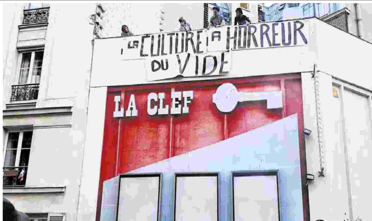
Il cinema La Clef con alcuni occupanti sul tetto foto di Revival La Clef
